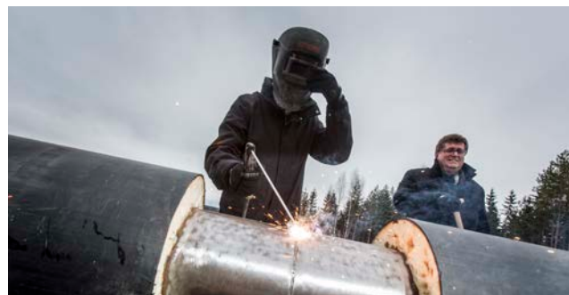
Jag svetsar och Janne Bohman står beredd att gräva ner fjärrvärmeledningen...
